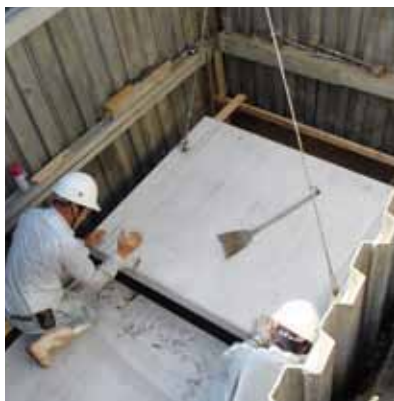
■ 基礎スラブ据付
