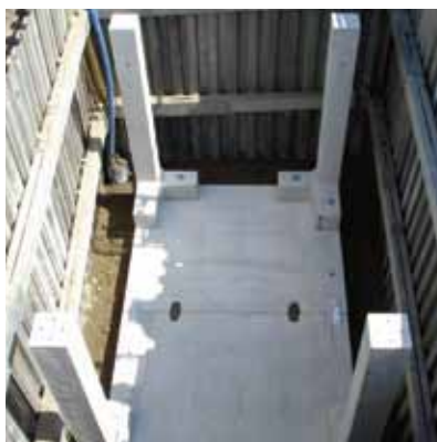
■ 製品据付完了
