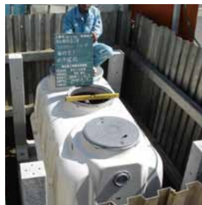
■ 浄化槽レベル確認
