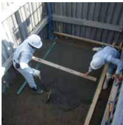
■ 基礎砕石・敷きモルタル敷均し
