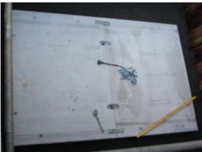
基礎スラブ据付完了
