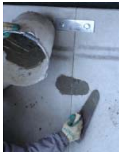
フランジ金具モルタル充填
