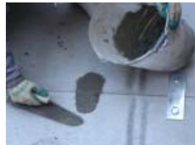
フランジ金具部 充填用モルタル
