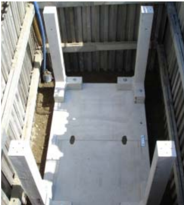
製品据付完了
