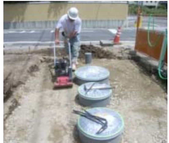
埋戻しをした後、十分な締め固めを行なう。
