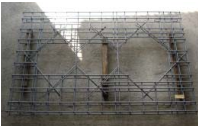
上部スラブ 加工鉄筋
